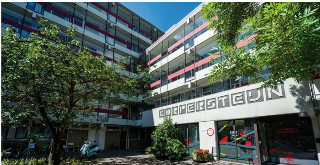
De huidige en de verbouwde Korpersteijnflat. Foto: Al Korpersteijn & foto Korpersteijnflat.
